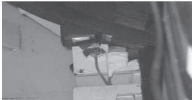
شکل هفت: محل نصب مقاومت در مسیر شانت معیوب
